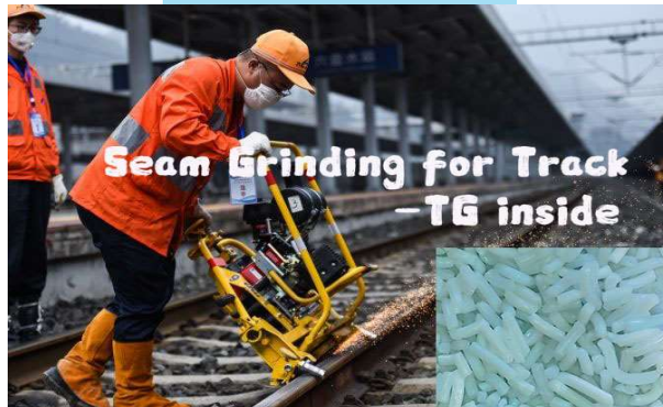
铁轨焊缝打磨
